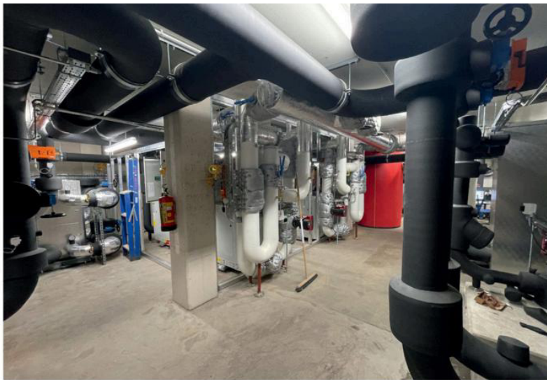
Nieuw gerealiseerde WKO en warmtepomp ruimte in de kelder van St Jansdal. Foto: Halmos
