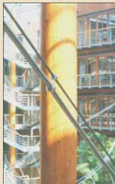
Detail leiding onder hangconstructie
